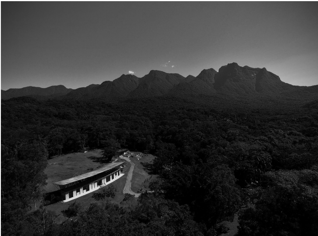
Foto 1: Pavilhão de oficinas – vista aérea
