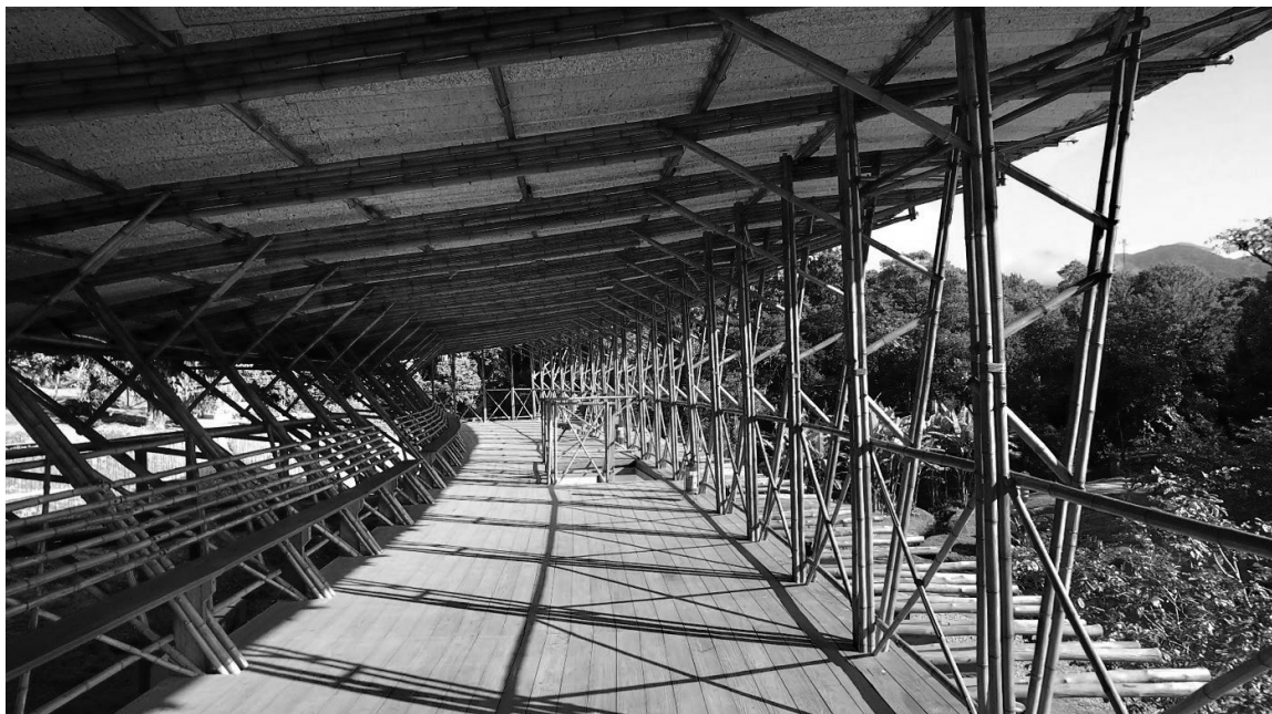
Foto 3: Pavilhão de oficinas - Vista interna primeiro pavimento
