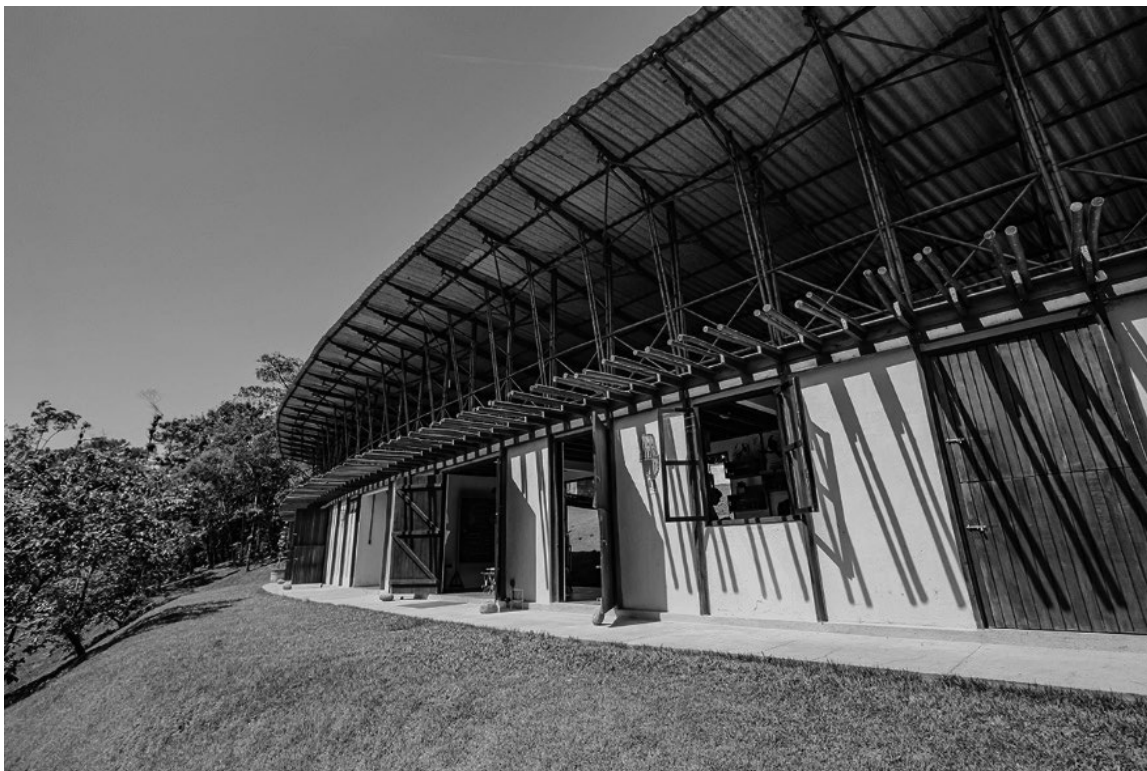
Foto 2: Pavilhão de oficinas
